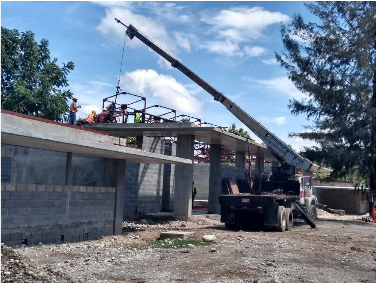
TRAVAUX D'INSTALLATION DES FERMES
